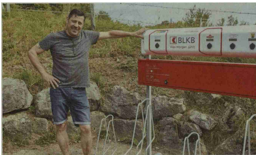
Sorgt in der Küche sowie an der Ladestation für «volle Batterien»: Gianni Fachin vom Bergrestaurant Meltingerberg.
